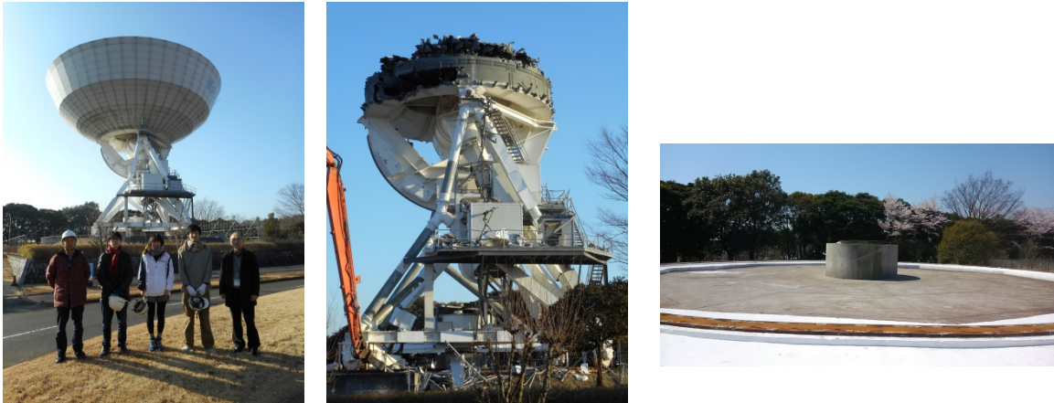
図1. 左から 2017 年 1 月 4 日（解体前日）、1 月 22 日（解体中）、4 月 14 日（解体後）
